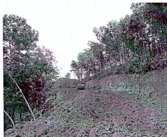
Thi công đường công vụ vào tuyến D4 Trường Sơn Đông – Quảng Nam
