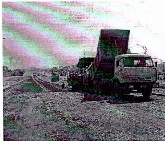
Thi công thảm bê tông công trình Cầu Rồng – Đà Nẵng
